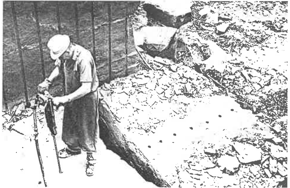
5 Manuelles Abbohren der hereingewonnenen Gesteinsblöcke, Bohrlochabstand 0,20 bis 0,30 m, für den Gattersägebetrieb.
